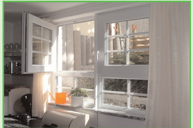
Drehkippfenster Nautilus Hybrid: öffnet nach innen, unten fix, ideal für Grundwasser
